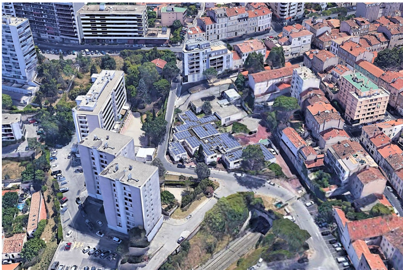
Panneaux photovoltaïques recouvrant les toits des école Chutes Lavie à Marseille. Source: Made in Marseille.
