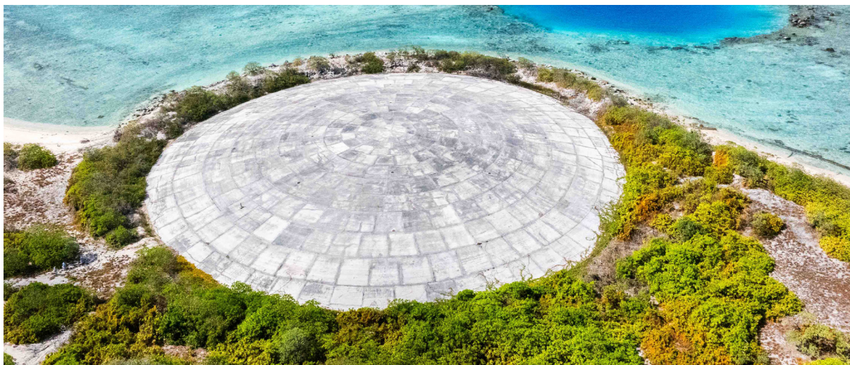
Le Runit Dome sur l'atoll d'Enewetak, dans les îles Marshall, est un dôme en béton de 114 mètres de diamètre rempli de déchets radioactifs provenant de décennies d'essais d'armes nucléaires américains. © Greenpeace / Chewy C. Lin
