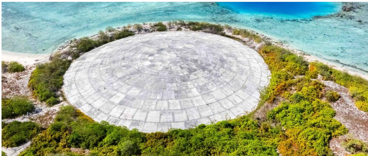
Le Runit Dome sur l'atoll d'Enewetak, dans les îles Marshall, est un dôme en béton de 114 mètres de diamètre rempli de déchets radioactifs provenant de décennies d'essais d'armes nucléaires américains.
