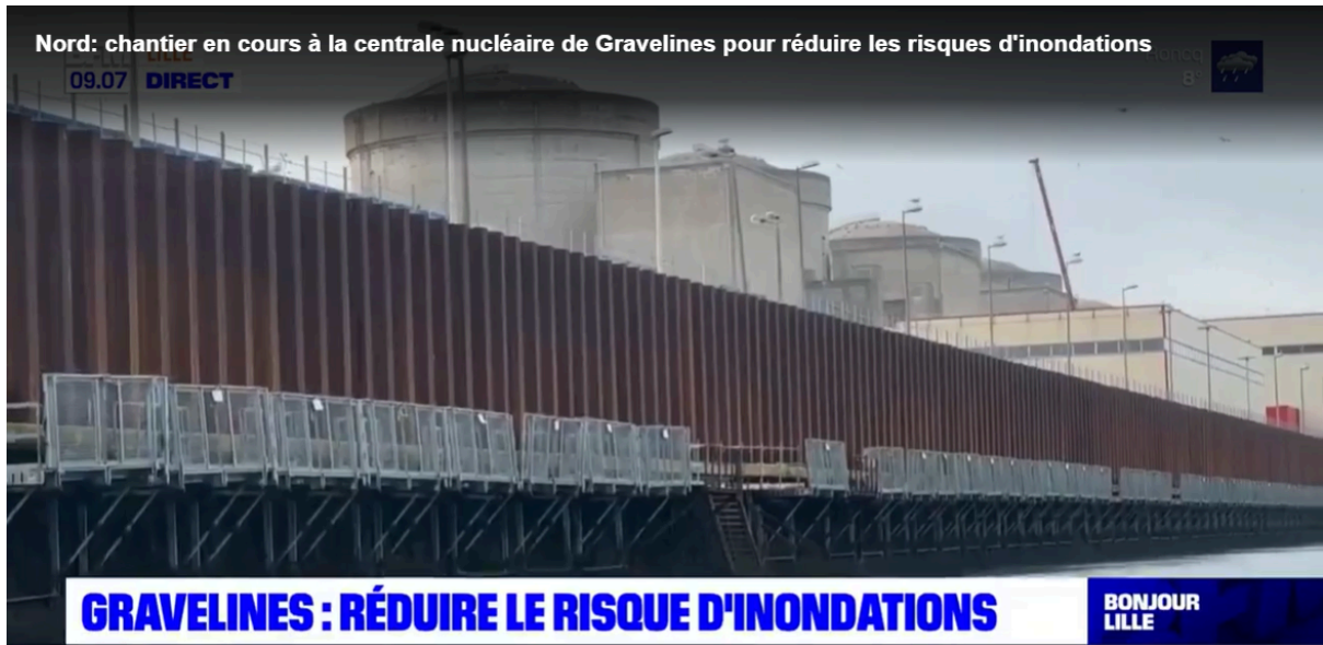
↑ Figure 6 : Bordure de palplanches d’une hauteur de 4 m d’après EDF 97 (Photo extraite d’un reportage BFM 98 )
