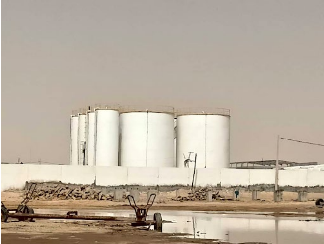
Réservoirs de stockage d'huile de poisson de l'entreprise Winterisation, en Mauritanie
